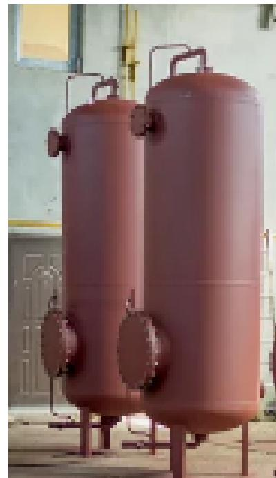
В процессе фильтрования жёсткой воды рабочая обменная способность натрий-катионита истощается и в дальнейшем происходит процесс регенерации натрий-катионита с вытеснением из него ранее поглощённых ионов кальция и магния 6%-ым раствором поваренной соли  $\text{NaCl}$ .
