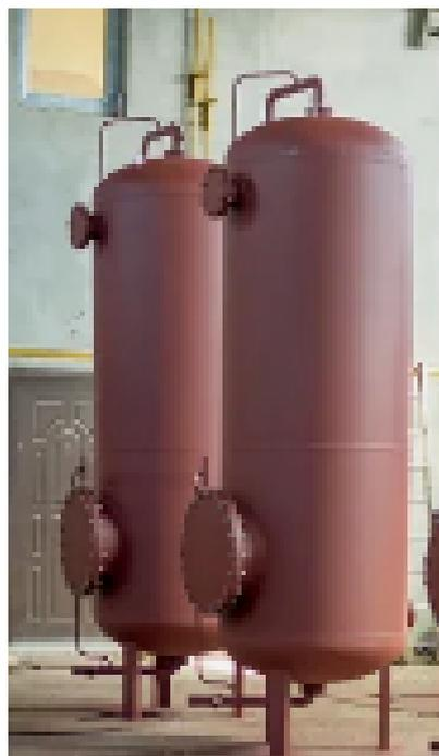
В процессе фильтрования жёсткой воды рабочая обменная способность натрий-катионита истощается и в дальнейшем происходит процесс регенерации натрий-катионита с вытеснением из него ранее поглощённых ионов кальция и магния 6%-ым раствором поваренной соли NaCl.
