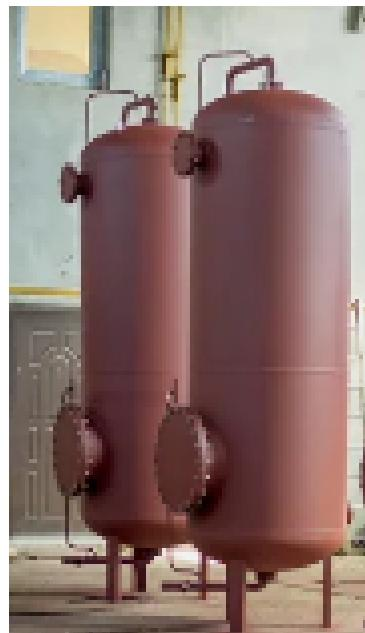
Осветление воды происходит в результате пропуска её через осветительный фильтр ФОВ-0,7-0,6, где грубодисперсные примеси воды методом прилипания к зернам фильтрующего материала, задерживаются на поверхности и в порах фильтрующего материала. В качестве фильтрующих материалов используется дробленый антрацит, кварцевый песок и мраморная крошка.
